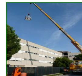
La centrale termica del complesso scolastico della Massa è stata sostituita da un nuovo generatore di calore a risparmio energetico (ad alta condensazione). Nel corso dell'anno 2010 è stato ottenuto il finanziamento per il progetto per la cappottatura (isolamento termico tramite pannelli a cappotto) dell'intero edificio scolastico (La Massa). I lavori di cappottatura sono terminati nel corso del 2012.
